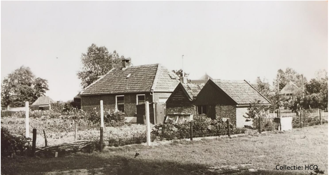
Bosweg 3 voor de reconstructie van Schellerenkweg en Bosweg in 1960.
