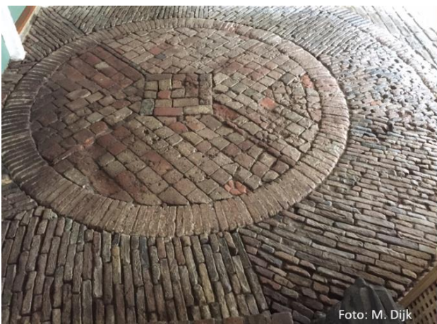
De nog aanwezige cirkel voor de tredmolen voor de karn, aan gedreven door een kidde [klein paard] tevens, nog in de stal aanwezige riem aandrijving voor wanmolen of bietensnij machine.
